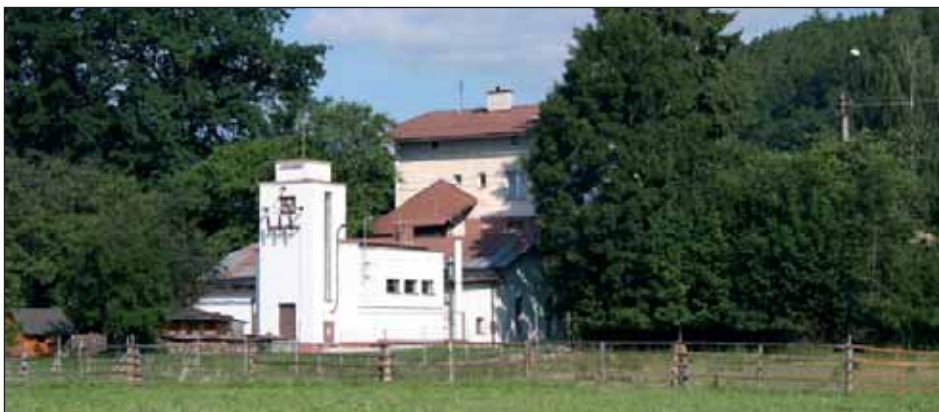
• Čerpací stanice Krnov Kostelec
