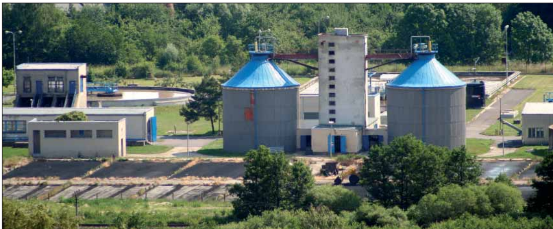
• Čistírna odpadních vod Krnov
