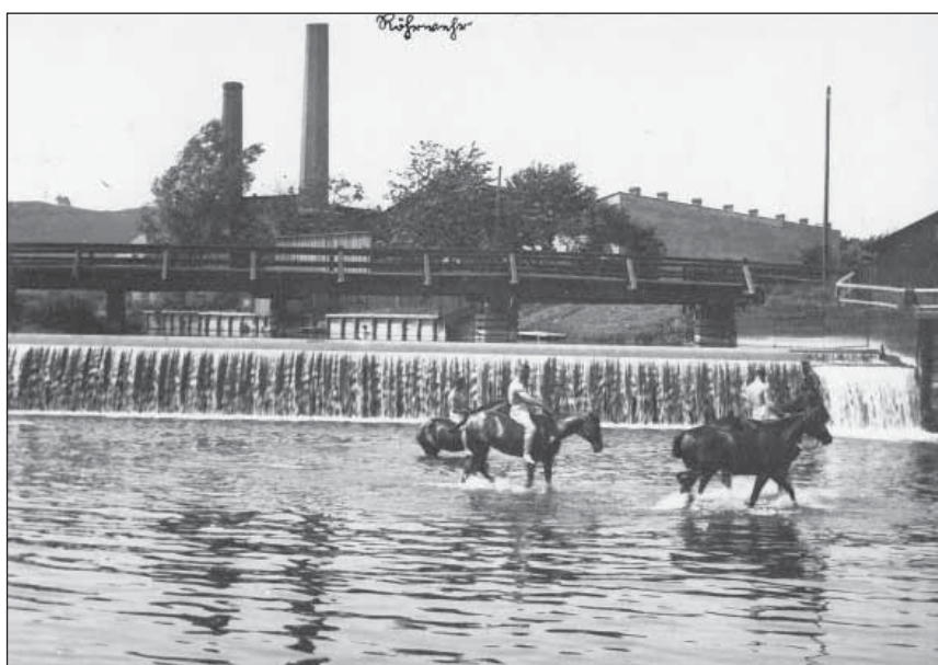
• Potrubní jez v Kostelci
