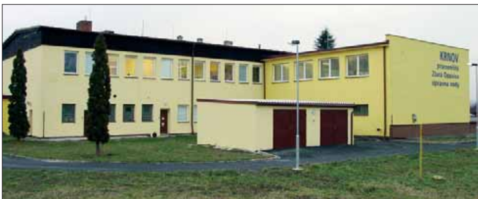
• Úpravna vody Krnov Zlatá Opavice
